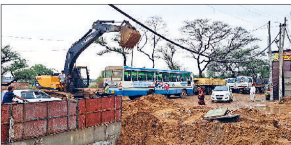
बाढ़ड़ा। बाढ़ड़ा के सतनाली रोड़ पर निर्माणाधीन पुल के समीप जाम में फंसे वाहन
